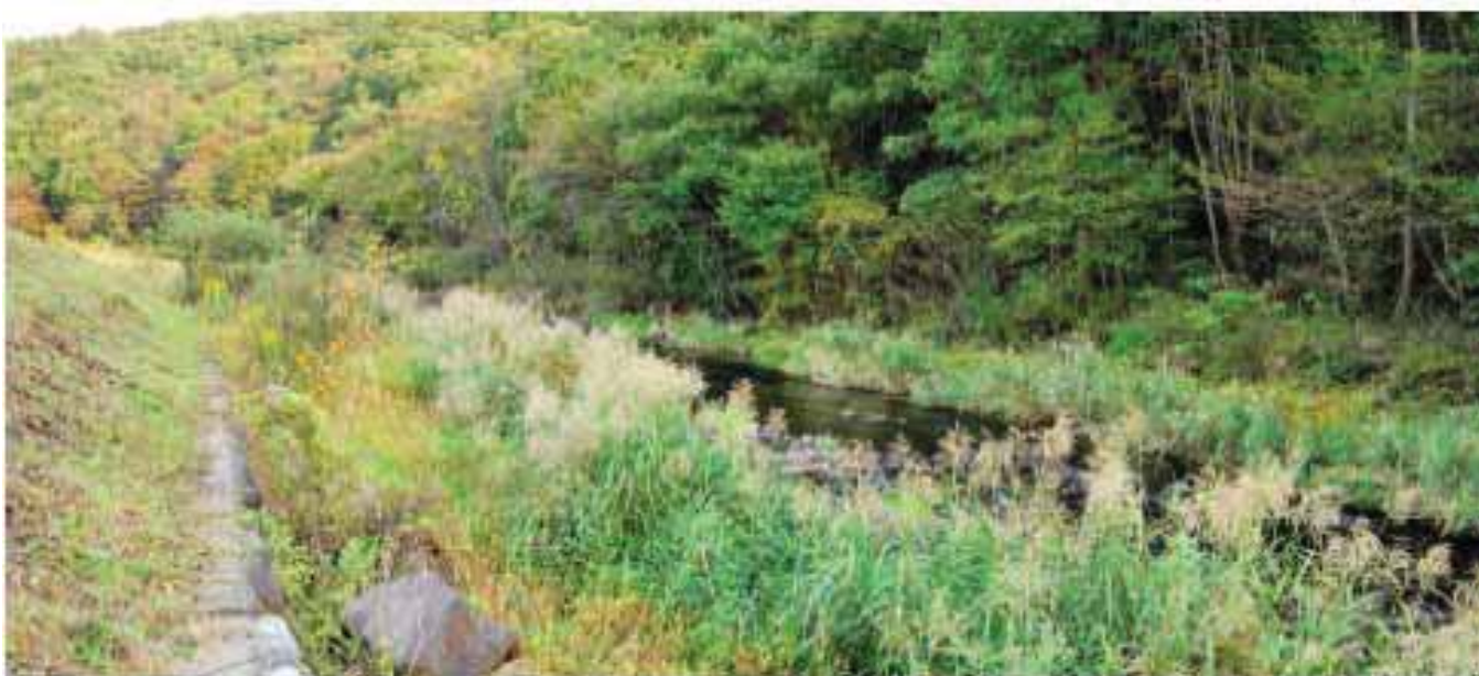
写真 4：山付部保全区間。左岸側（写真左）の護岸前面にも植生が回復し自然な水辺になっている。
