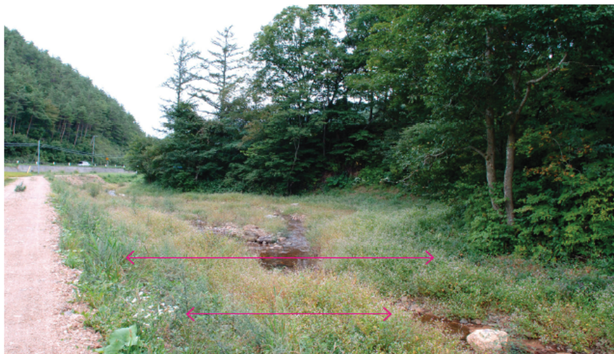
写真 4：山付部を保全し、片側を拡幅した区間。＊山附の河岸は蛇行しているため川幅は変化する。川幅の変化は川の作用に
