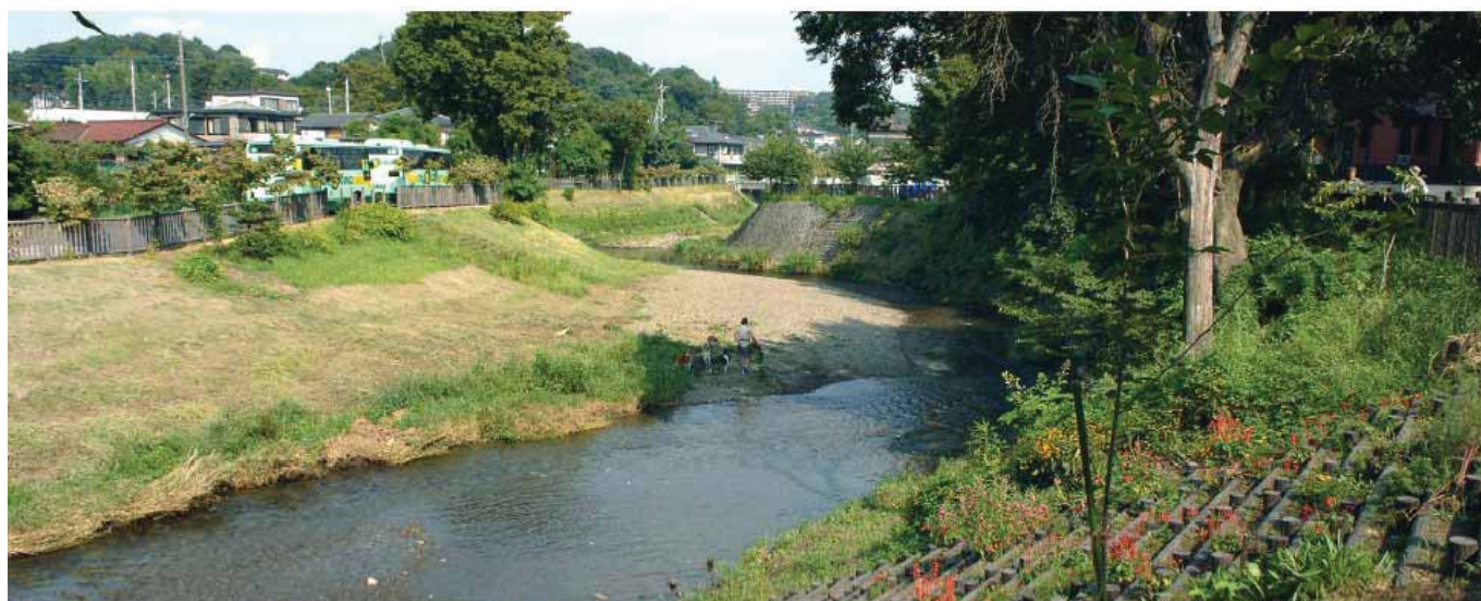
写真 8：写真 7 の上流側から：川の自然性回復のポイントは川幅が広い（川の自由度が高い）ことである。
