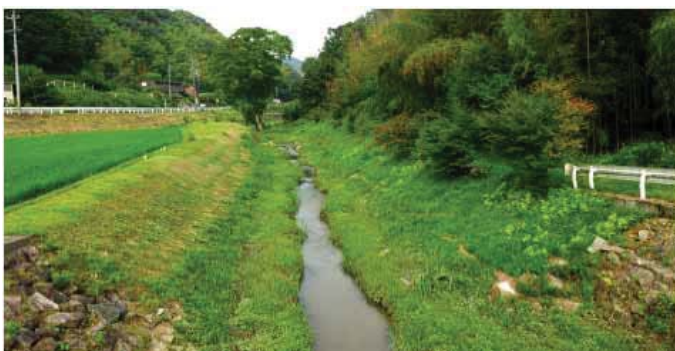
写真 3：直線区間。両岸とも 2 割勾配。画一的。
