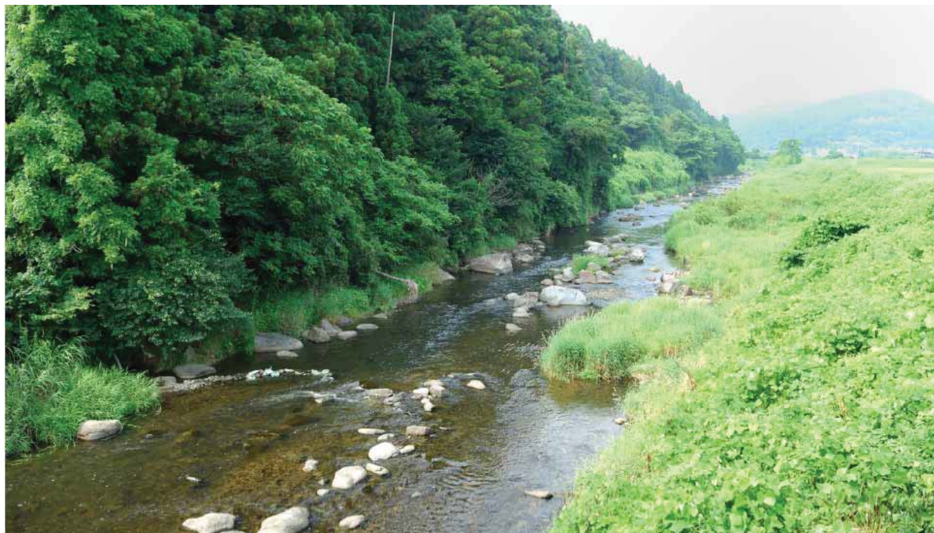
写真 1：山付部を保全し片岸だけを拡幅した区間。現場の大礫を利用し、流れの多様性が保たれている。
