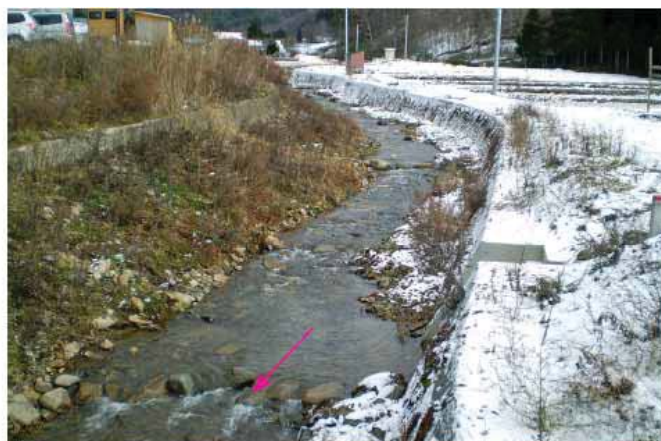
写真 16：非対称の河岸（外岸が立ち内岸は緩やか）
