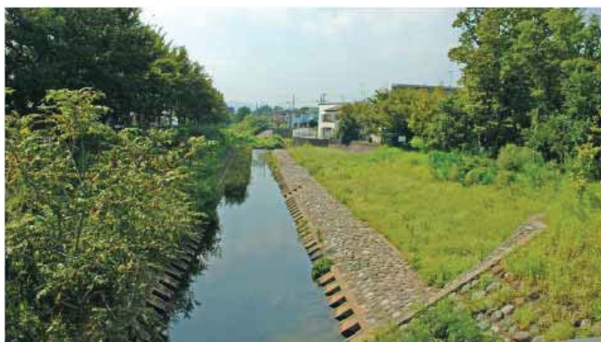
写真 6：旧河川蛇行部の高水敷：標準断面を前提としているので単調な断面となった。
