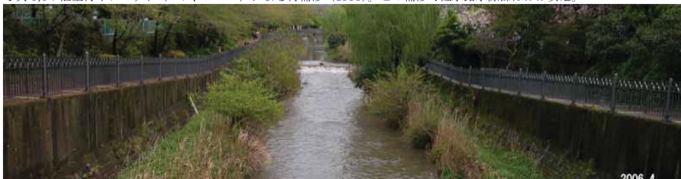
写真 5,6：植生付ヤシマット（ヨシ、マコモ）による再補修（1999）。この補修で低水路水際部はほぼ安定。
