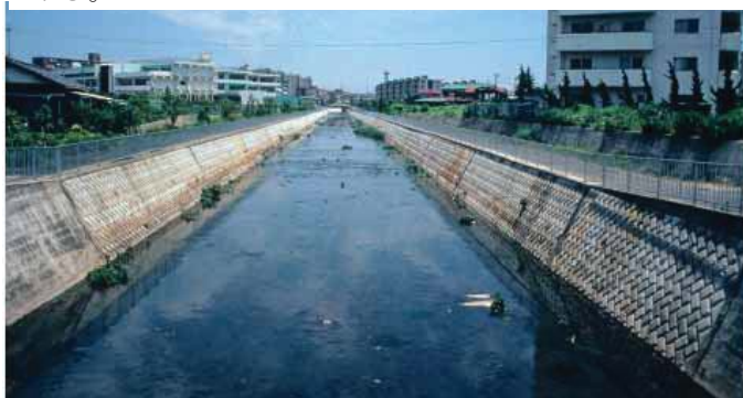
写真 1：低水路施工前。水深浅く単調な流れ
