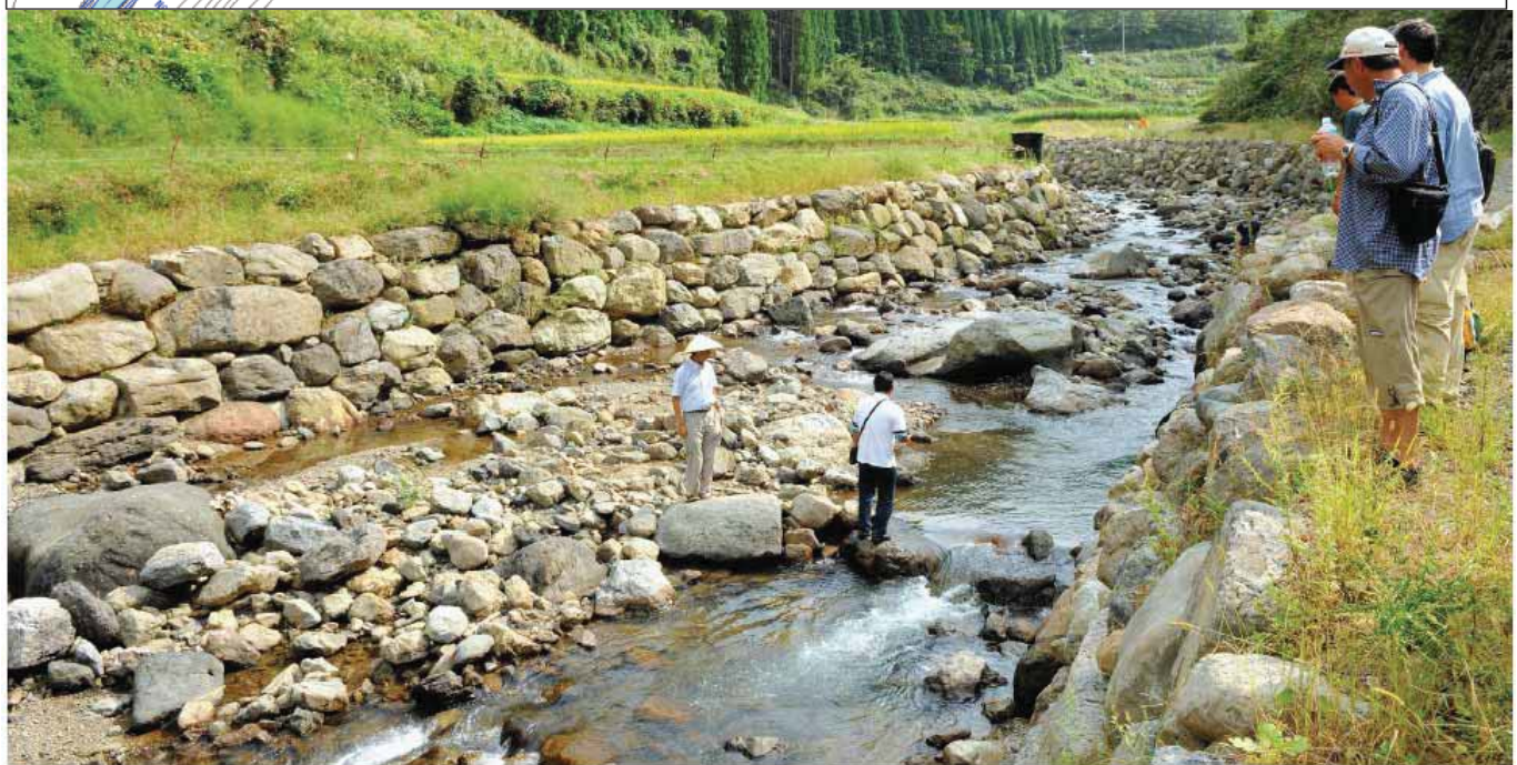
写真 4：転石を河床に再配置して多様な流れを回復する。再配置された転石は自然の落差として機能し、河床の安定に役立つ。
