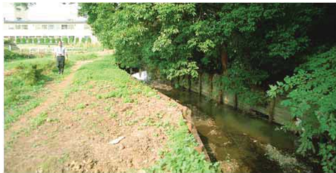
写真 1：改修前（1992）：板柵護岸
