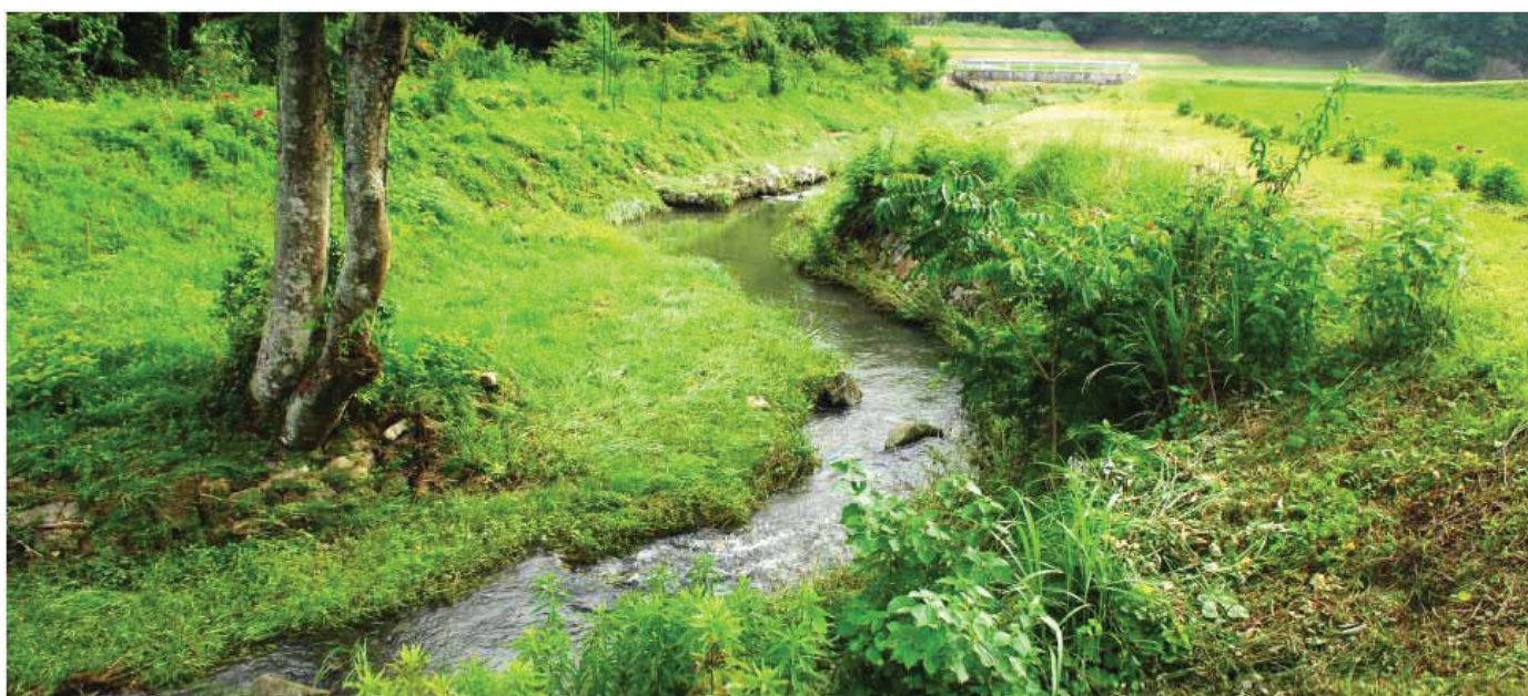
写真 7：河岸の樹木を保全した区間。現況のよいところを残すということが河道計画の基本といってよい。樹木を残すことで河道の形態も保全される。
