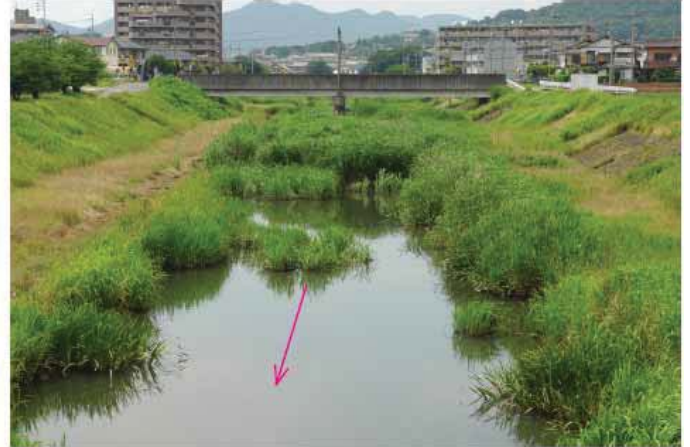
写真3：青木橋下流環境水制工（手前：交互配置） ＊適度な植生回復。
