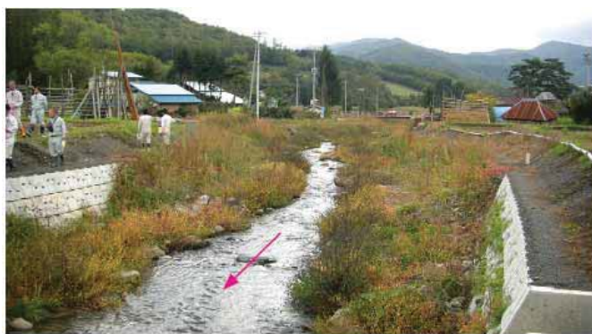
写真 4：1k025 付近施工後（2008.10）
