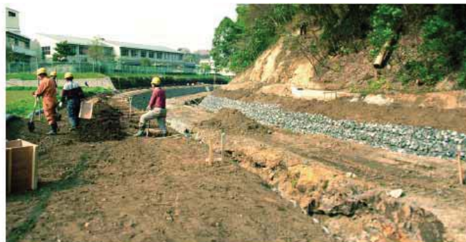
写真 2：改修工事（1993）：左岸は計画どおり施工。右岸は蛇籠護岸とし管理用通路を取りやめた。
