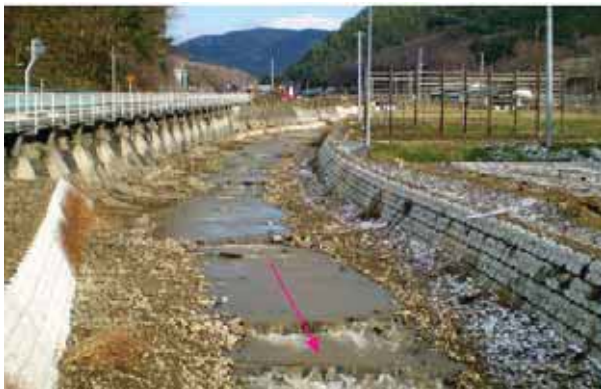
写真 3：0k325 付近（2008.12） *寄せ石と置き石の配置状況
