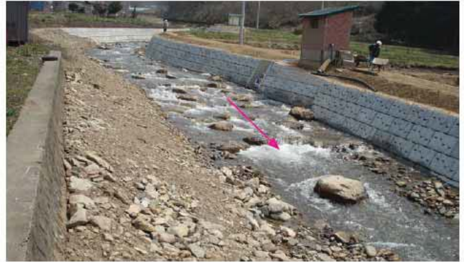
写真 9：置き石による分散型落差工
