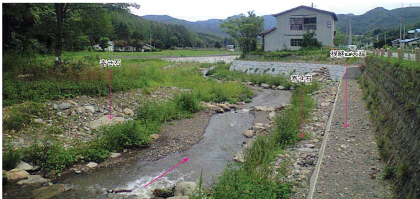
写真 14：既設護岸根継工天端処理
