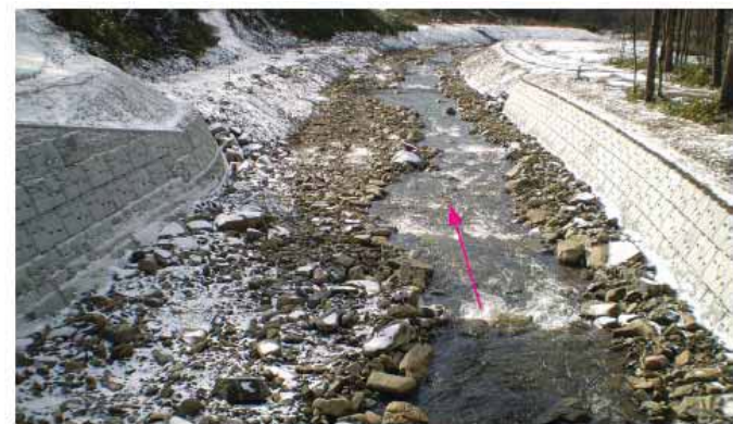
写真 11：現地発生材を利用した濬筋形成
