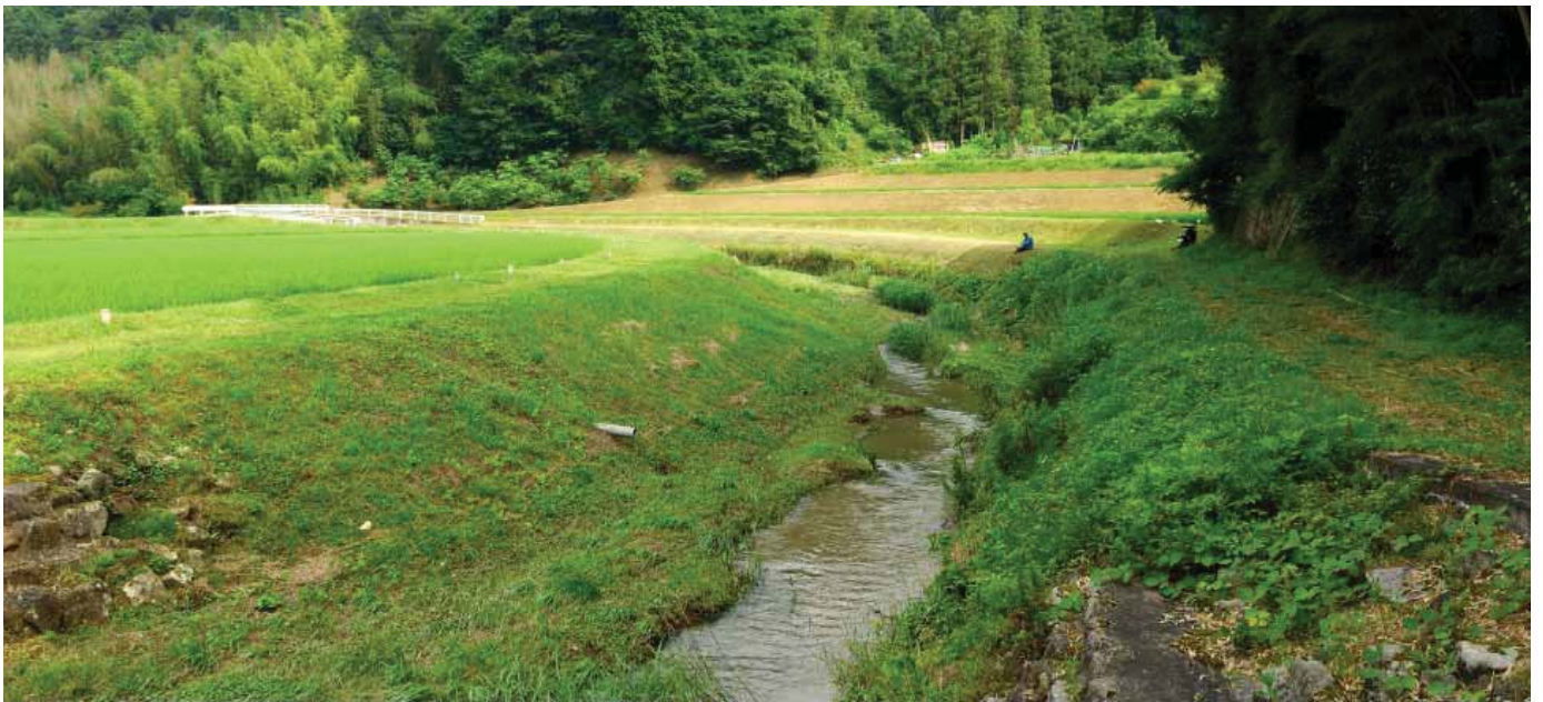
写真 1：蛇行部。内岸は 2 割勾配で、外岸は 5 分勾配の石積で施工している。河岸形態はより自然である。
