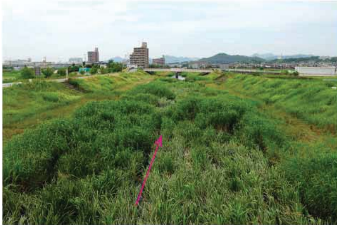
写真2：青木橋下流環境水制工（対面配置） ＊河床全体に植生が繁茂している。
