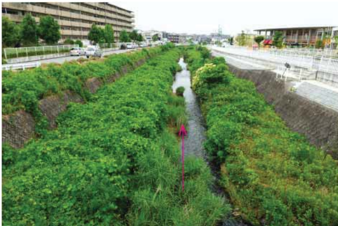
写真 1：富士浦橋下流低水路：水際は蛇籠で固めた区間。水際は固定されているので流路が単調である。
