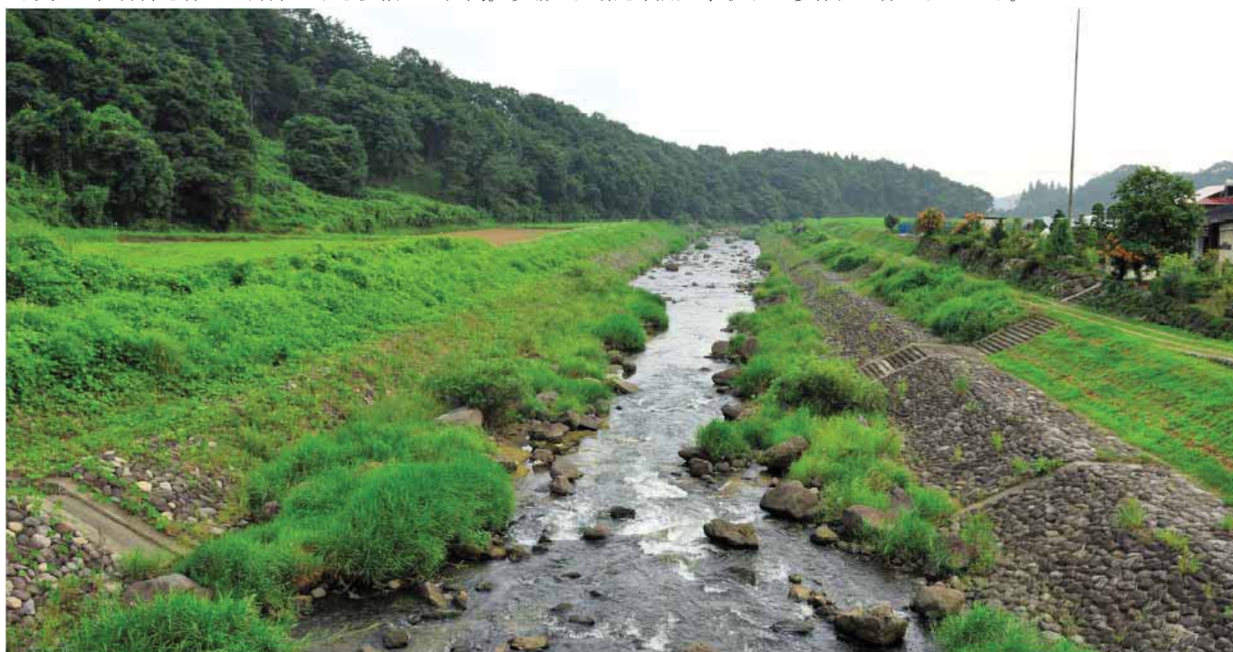
写真 2：標準断面区間。寄せ石をして水際構造を自然にする努力がなされている。低水護岸を立て河床幅（水際域）を広くすると、滞筋の多様性をさらに増すことができると考えられる。
