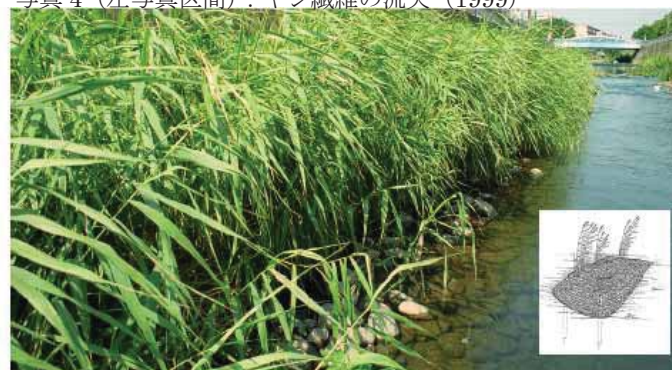
写真 5,6：植生付ヤシマット（ヨシ、マコモ）による再補修（1999）。この補修で低水路水際部はほぼ安定。
