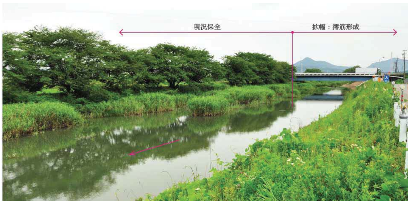
写真 1：塔野地橋上流の片側（左岸）拡幅区間。
