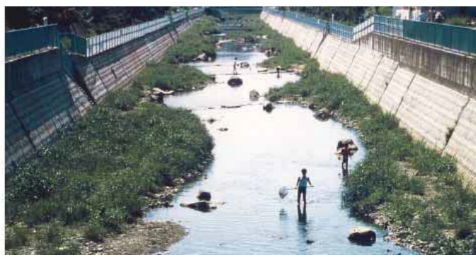
写真 2：施工後約半年。交互砂州をイメージして設計
