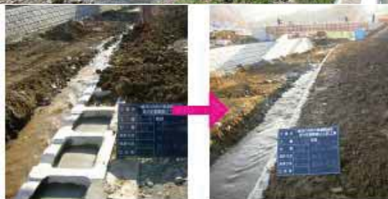
写真 12：河畔林の保全／護岸天端の処理（土埋戻）
