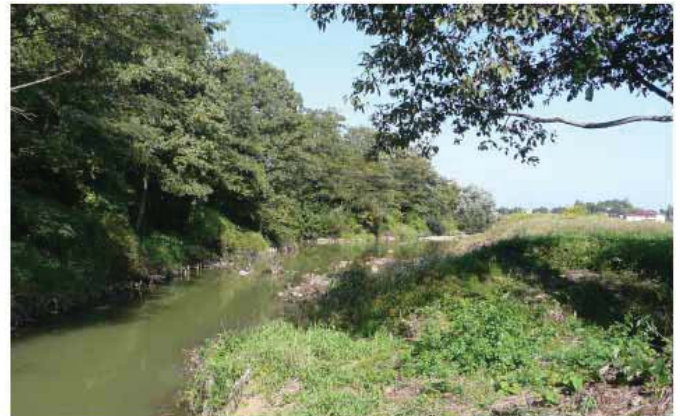
写真 3：片側拡幅整備後（サギコロニー付近）
