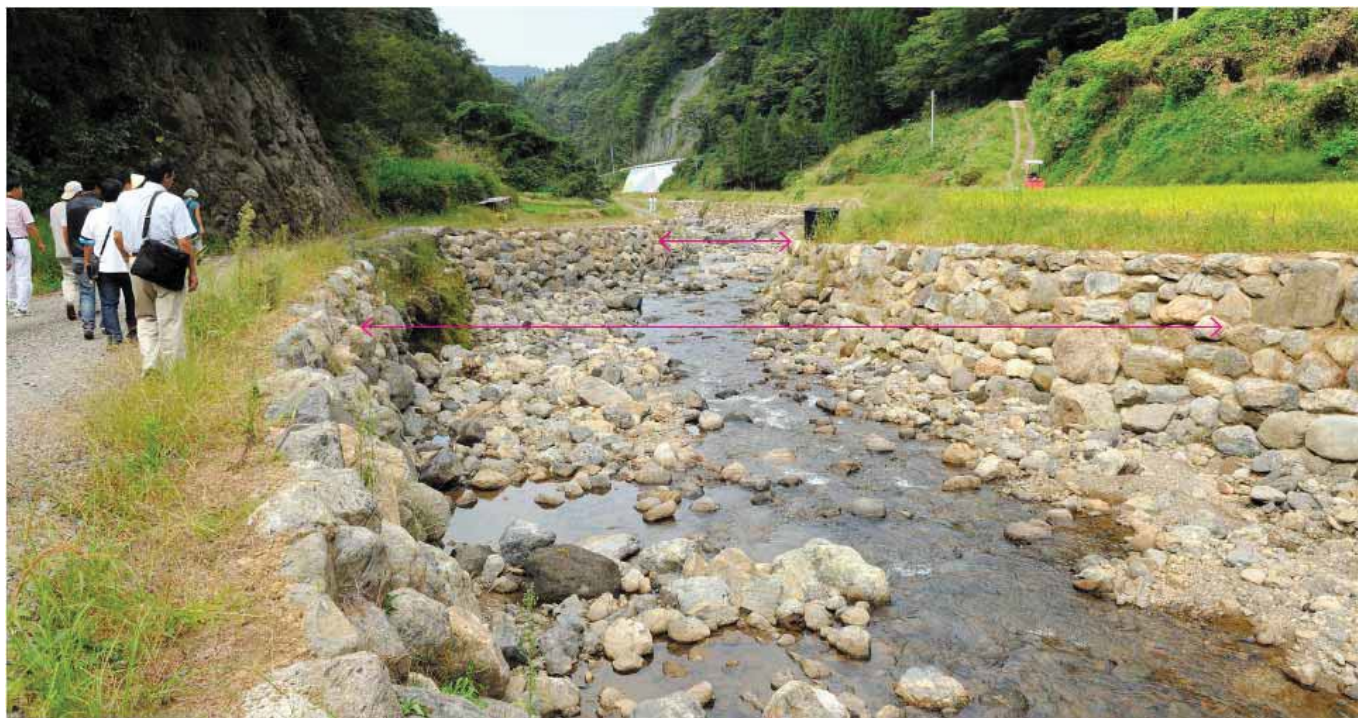
写真 3：川幅の変化。河岸がえぐられて川幅が広がったところは広がった川幅に合わせた改修をした。
