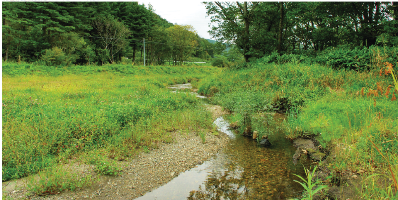
写真 5：当初設計を見直し旧川蛇行部を埋めずに新河道と一体的に整備した区間。
