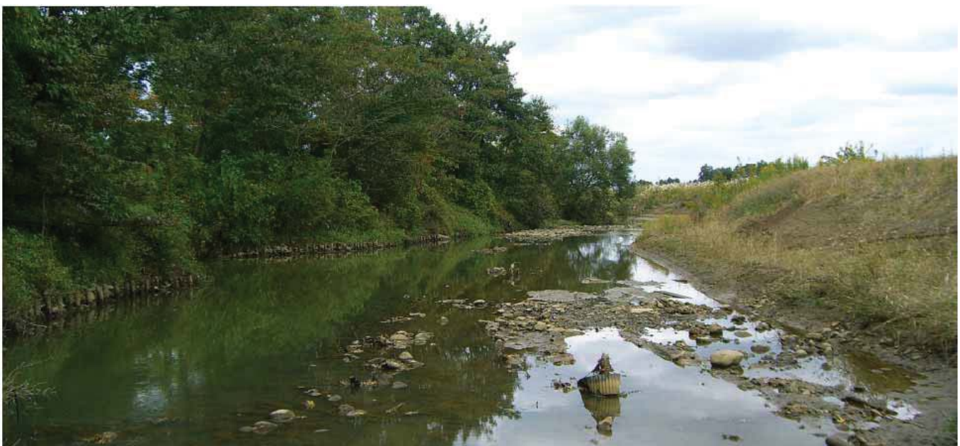
写真 4：片側拡幅整備後：河畔林と従前の滞筋が保全されている。
