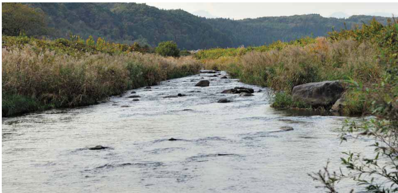
写真 3：水際部の様子。寄せ石の間に土砂が堆積し自然な水際になっている。河床に存置した大礫は流れに変化をもたらしている。寄せ石配置は水際構造の多様性回復に効果的である。
