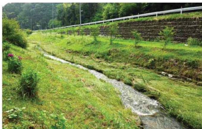
写真 5：5 分から 2 割勾配への変化点をうまく処理している。
