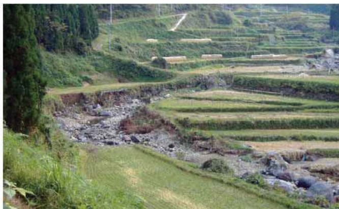
写真 2：被災直後。川幅が広がっている（横侵食）。
