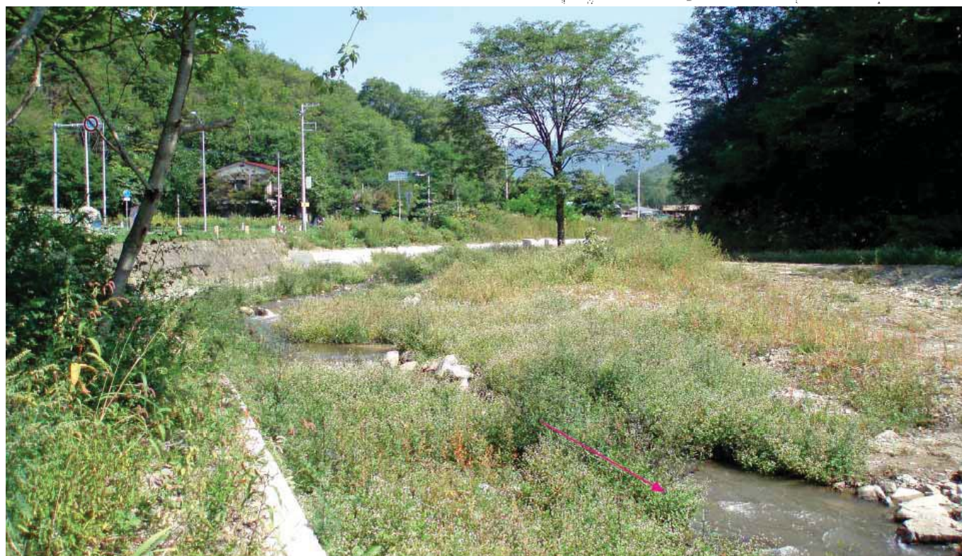
写真 7：山付部施工後（2008.9）
