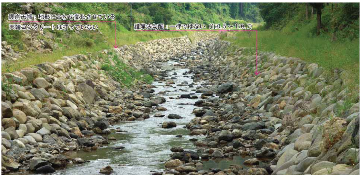
写真 5：川幅や護岸のり勾配を河道特性に応じて変化させた。護岸表面のテクスチャー、護岸天端の柔らかさ（天端コンクリートを打たないで）で周囲と調和した景観としている。
