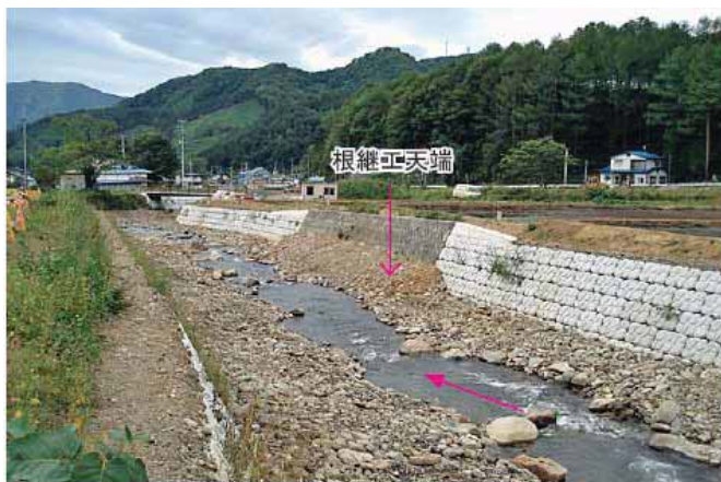
写真 15：既設護岸根継工天端処理
