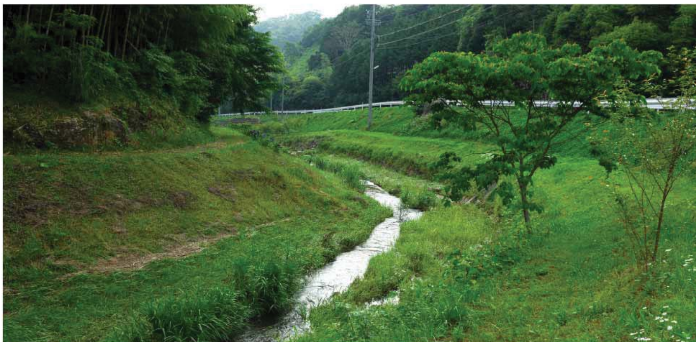
写真 4：蛇行部。山付部を削っているが、山の地形構造と河岸（法勾配）の連続性が保たれているので違和感はない。内岸が寝て外岸が立つ形状は自然である。川幅に工夫の余地がある。
