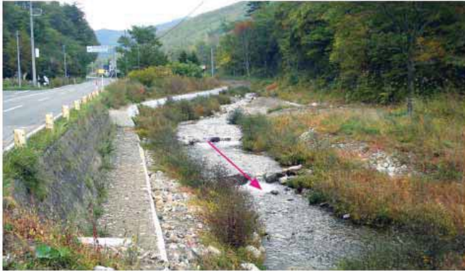
写真 8：置き石によるステップアンドプール
