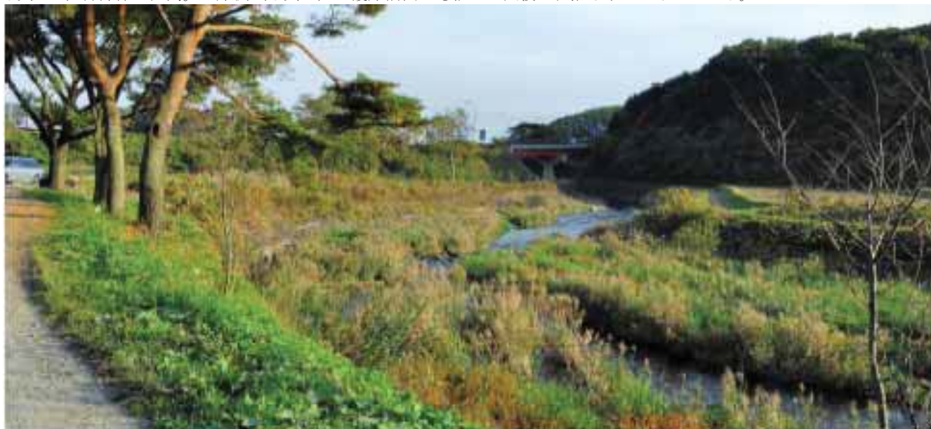
写真 5：河畔林を保全した親水スポット。根固工を深い位置に入れると淵の形成を許容できたと考えられる。
