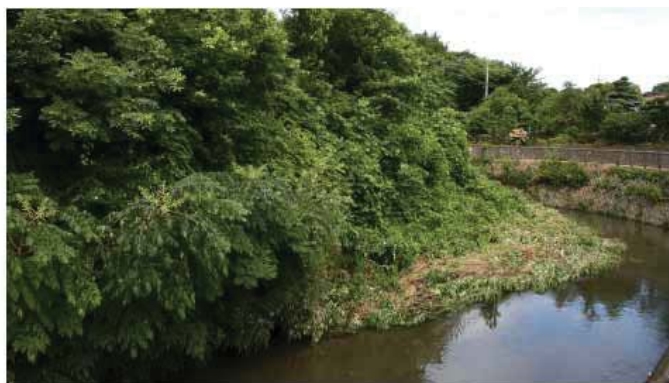
写真 5：7 年目（2007.7）：河岸は自立している。 写真提供：境川の斜面緑地を守る会
