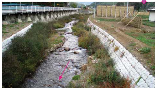
写真 2：0k325 付近施工後（2008.10）。 *河床幅を広くとり寄せ石等で多様な流れを創出。
