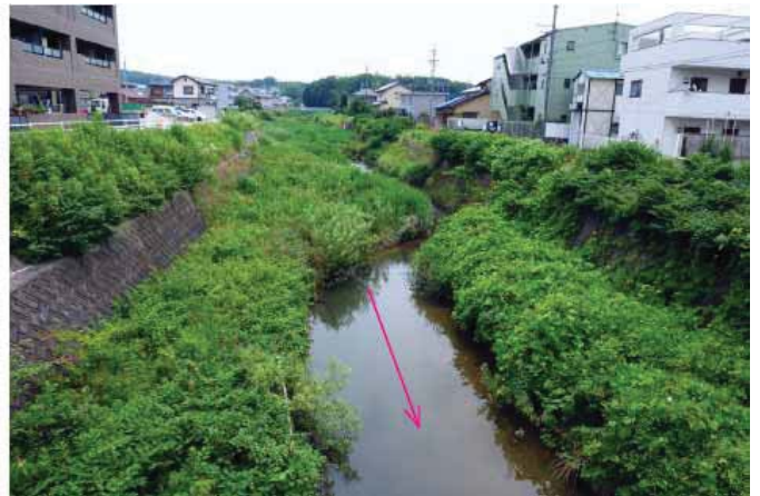
写真 2：富士浦橋上流低水路：水際はフリーにした区間。東海豪雨で低水路が蛇行した。
