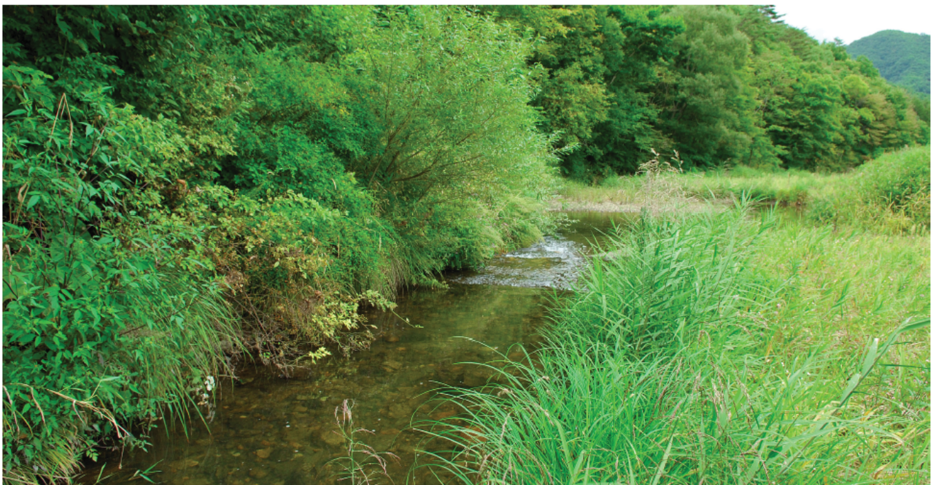
写真1：山付部の河岸と河床をそのまま保全し対岸を拡幅した区間。この場所の川らしさが保たれている。
