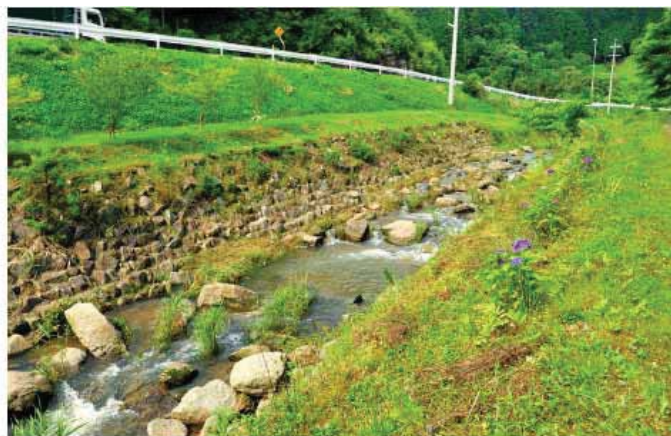
写真 6：巨石を分散して配置した分散型落差工。落差工に魚道を設置するやり方と比べるとより自然的である。巨石のサイズや配置の仕方に工夫がいる。
