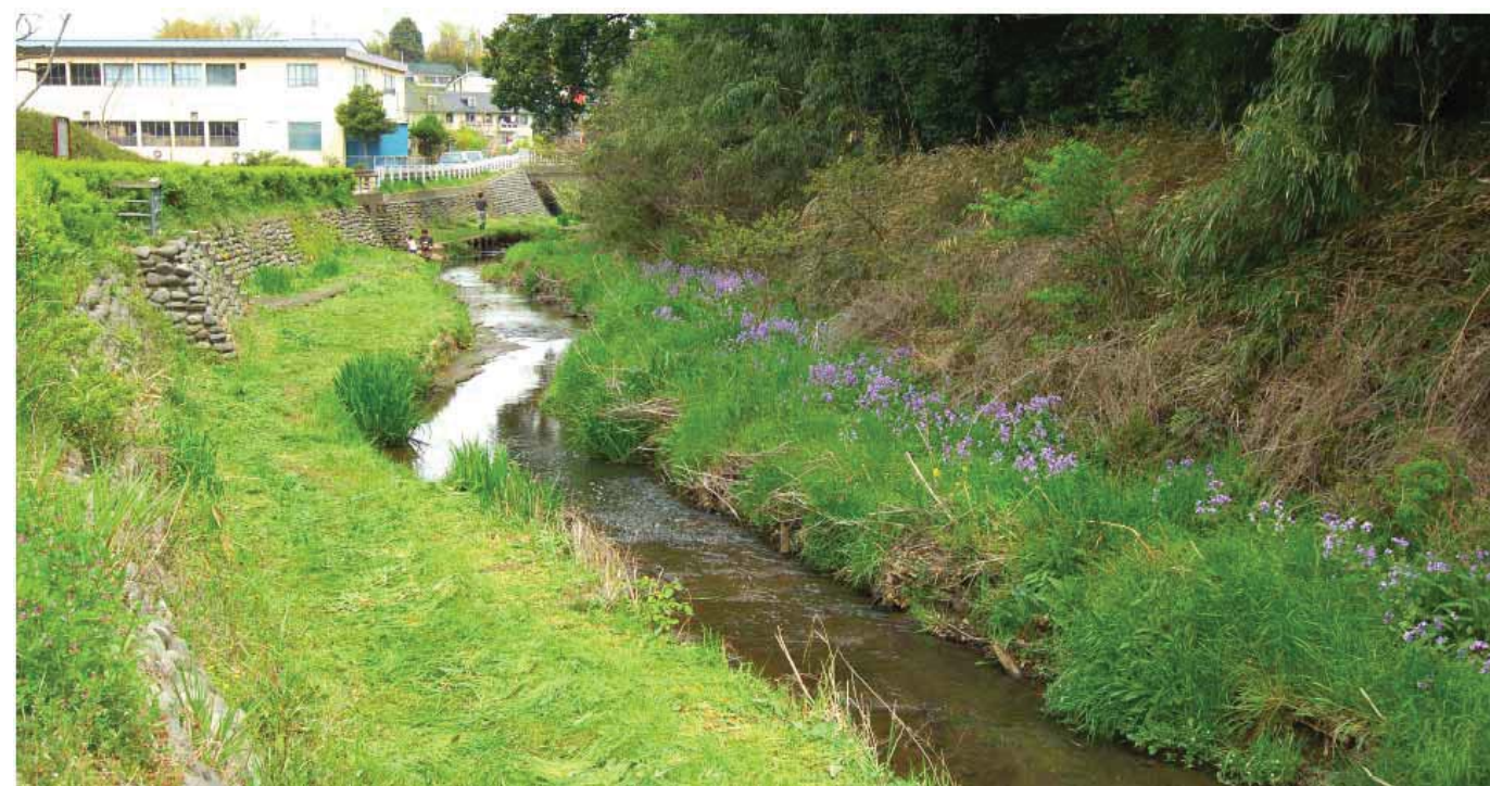
写真 5：施工後 13 年（2007）：山付部蛇籠は崖の地形（平面的な凹凸）にあわせているので、川幅が 1～2m 変化している。斜面林と川との自然的なつながりは保たれている。左岸石積もあまり目立ってない。
