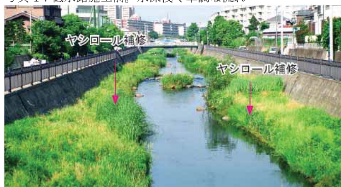
写真 3：ヤシ繊維ロールを用いた補修（1993 年度）
