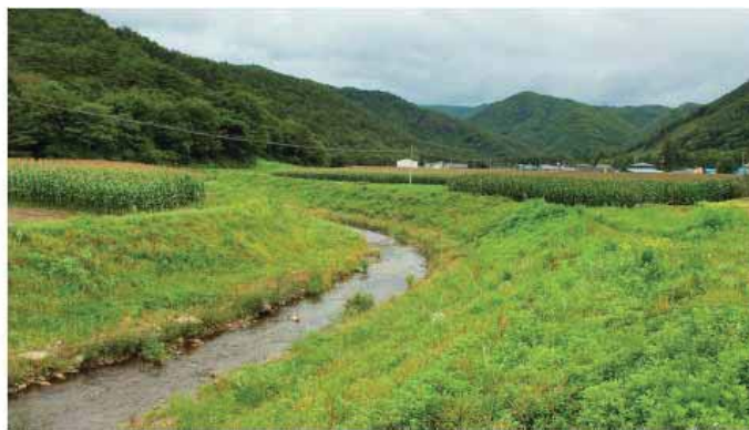
写真 3：標準断面区間。写真 1 と比べて画一的・単調。
