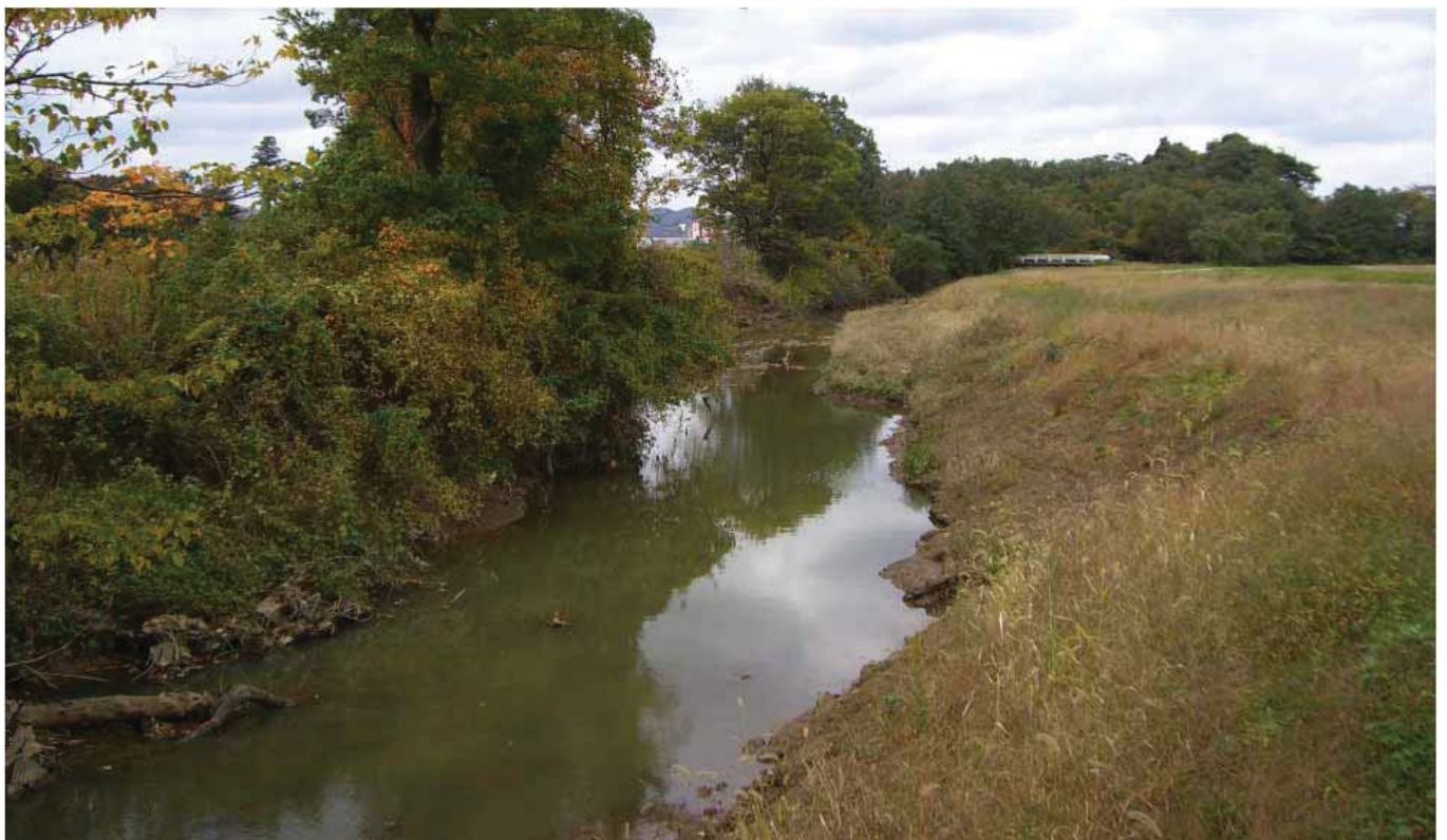
写真 6 : 片側拡幅整備後（サギコロニー上流）
