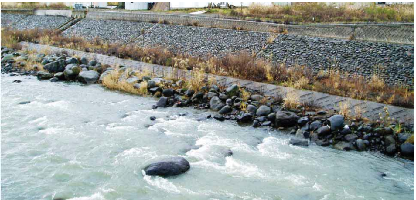
写真 2：寄せ石を配置しなければ直線的な水際構造になる。寄せ石を施すことで、この川の元々の水際構造に近い形になる。寄せ石の配置（幅や高さ、礫径など）の仕方に工夫の余地がある。
