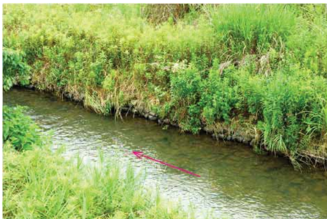
写真 3：水際部を蛇籠で固定した区間。低水路（盛土部）の植生は陸生のものが主体。
