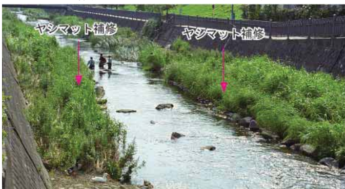
写真 5,6：植生付ヤシマット（ヨシ、マコモ）による再補修（1999）。この補修で低水路水際部はほぼ安定。
