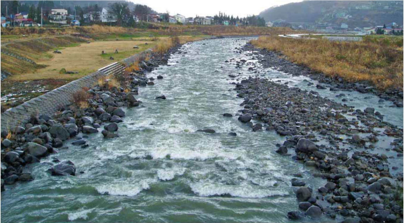
写真 1：寄せ石を施すことによって水際部に凹凸ができ自然な水際構造になっている。
