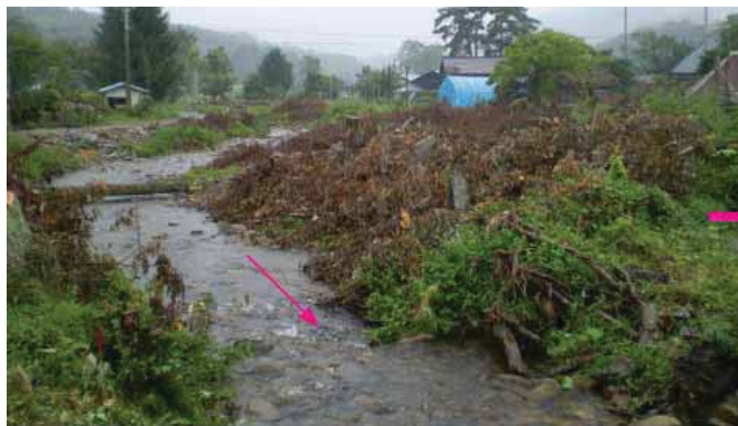
写真 5：1k000 付近施工前（2007.8）
