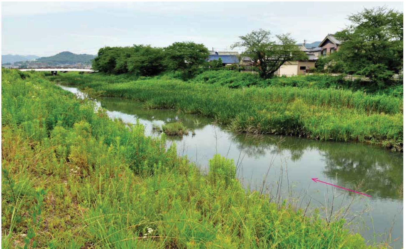
写真4：塔野地橋上流片側拡幅区間。 ＊片側拡幅により桜並木や水際植生が保全され、河川改修によるダメージは最小限に抑えられている。 ＊全面的な改変区間（写真2～3）と比較して、水際植生や滞筋は格段に自然的である。 ＊堆積や植生回復によって現在の滞筋が変化する可能性もあるが、写真2のような植生繁茂はおきないと考えられる。
