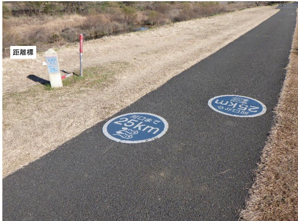
図 21 距離標と路面標示を併用した例（多摩川 川崎市）
