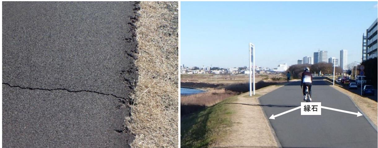
図 43 舗装端部から損傷（左）、舗装端部に縁石設置（右）
