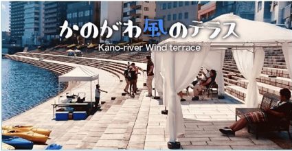
かのがわ風のテラス 階段護岸（静岡県）
