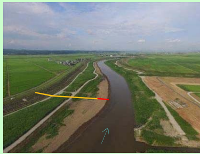
H28.8.3 (掘削完了 H28.8)
