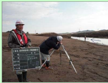
H28.12.20 (掘削完了直前) 掘削完了H29.1
