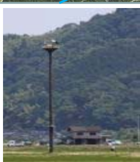
県・市が設置した 人工巣棟整備
