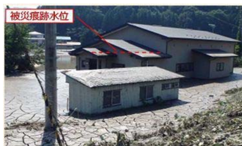
浸水解消後の流入土砂堆積状況
