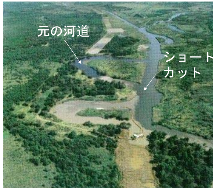
釧路川の捷水路掘削（河川のショートカット）
