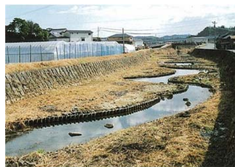
河川特性を把握せずに、人為的に川を蛇行させたため、瀬・淵が形成されていない。
