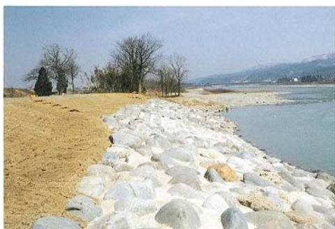
自然石を使ったものの、水際を固めたため空隙がなく生物の生息・生育環境を悪化させてしまった。
