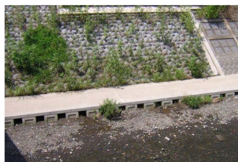
魚巢ブロックをとりつけたが、前面に州がついてしまい、魚巢ブロックが機能していない。
