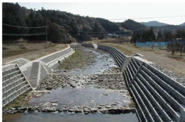
標準断面を採用し、左右岸の護岸に植生を促すよう工夫した施工例
