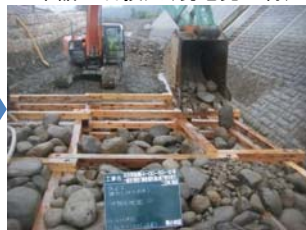
中詰玉石投入(現地発生材)
