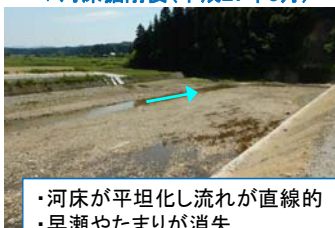
▽河床掘削後(平成27年6月)
