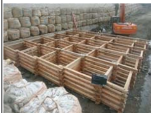
木工沈床組み立て(県産材)
