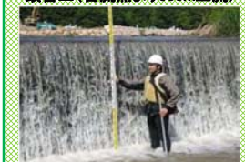
落差工(人面橋上流)
