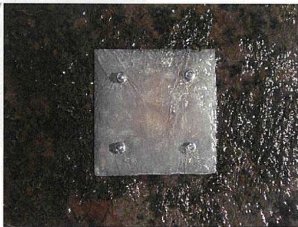
岩盤に固定したFRP板 FRP板(左:完成、右:加工前)
