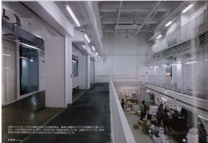
2階半のトワークから3階の遊園地の店舗を見る。車庫も駅構も1階の組屋が入居しているが、この空間を有するだけで、多岐の用途が併存している。古物のスロープで、既存建物の旧部と建築部分に約200mmのレベル差を解消している。
