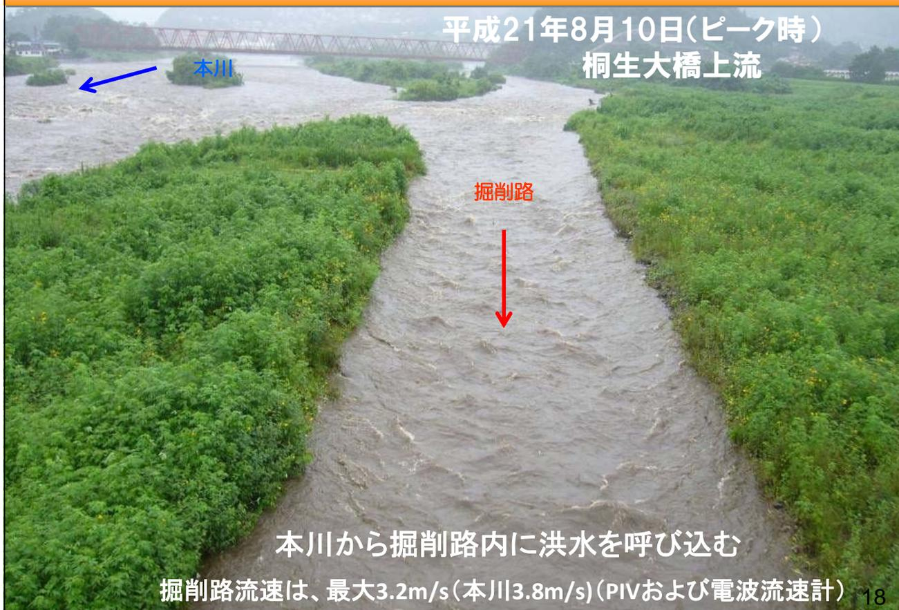
5. 掘削路による洪水攪乱の状況 桐生大橋地点における洪水観測
