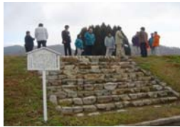
堤防階段の整備
