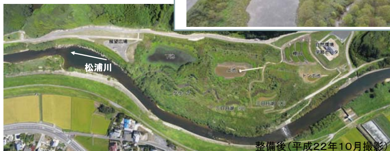
整備後（平成22年10月撮影）
