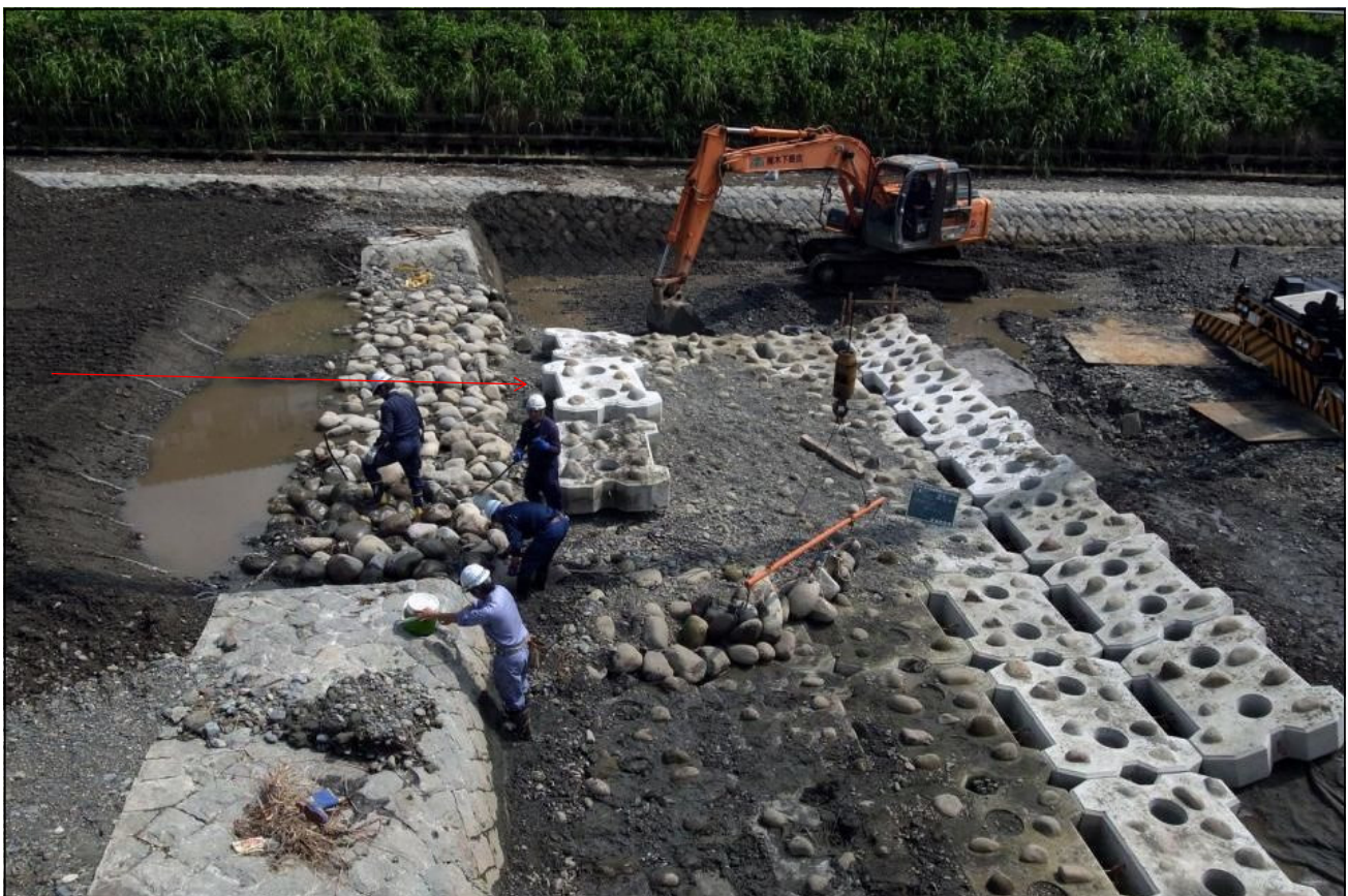
水通し付床止め工 (h=0.6m)
