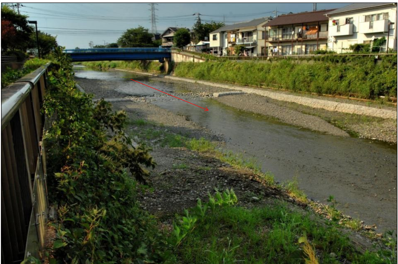
床止め工 2012.9.7(工事後2ヶ月)
