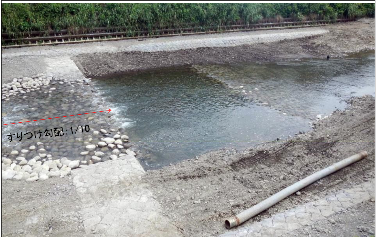
床止め工完成直後 2012.7 写真提供:東京都
