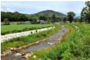
写真10 元町川(岩手県)の低水路。現場の河床材(大中小の礫)を水際に寄せる形で低水路を形成している。写真の水際部に見える礫は、水際を固定するためのものではない(写真11)。
