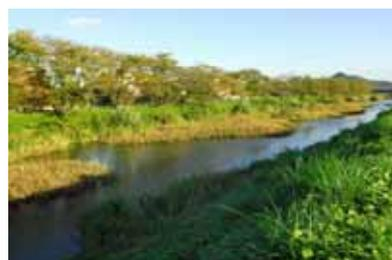
写真3 片側拡幅・みお筋(水際)保全(愛知県新郷瀬川)。片側拡幅とすることによりみお筋(水際構造)を保全した。
