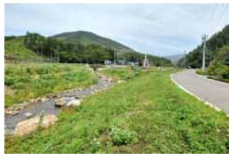
護岸の前面に河岸を形成した事例
