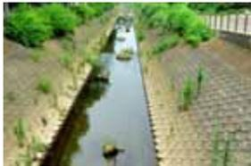
緩勾配護岸を採用したことにより、護岸面積が大きくコンクリートの使用量が多い。
