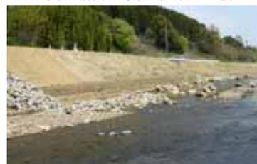
護岸の前面に河岸を形成した事例
