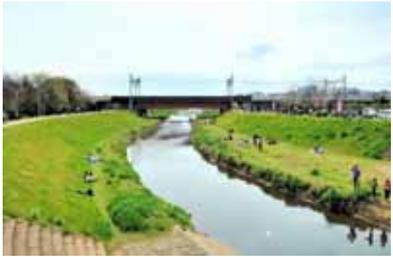
写真6 複断面(標準断面)区間の黒目川(埼玉県)。左の写真と同じようなカーブであるが、低水路幅がせまく、内岸には寄州が形成されていない(堆積させるスペースがない)。低水路の外岸はカゴマットで防護されているため、内岸側がえくれている。
