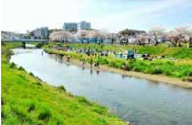
写真5 単断面に変更した区間の黒目川(埼玉県)。河床幅を広く設定しているため、川が運んできた砂礫が堆積して内岸に寄州が形成されている。川の働き(堆積や洗掘)のためのスペースを確保するという考え方が重要である。
