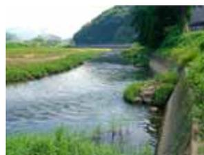
護岸前面に設置した水制。護岸そのものは間知ブロックであり多自然としては問題が残るが、水制は水際の直線的なラインを和らげている。
