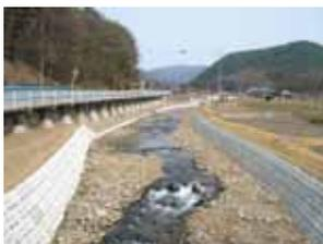
寄せ土による水際の保全例。護岸法線は直線のだが、水際のラインは複雑となっている。
