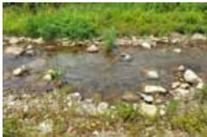
写真11 元町川(岩手県)の低水路。真上から見ると、大中小の河床材を寄せ石していることがわかる。水際に大きな石を並べてみお筋を固定するやり方は全く異なる。水際を河床材で再生するという考え方が根底にある。
