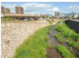
護岸前面の水際部に植生が繁茂した事例。護岸の境界を不明瞭にするだけでなく、水中から繁茂する植生は生態場として機能する。
