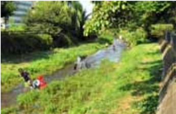
写真12 落合川(東京都)。低水路幅にゆとりがあるため、水際に土砂の堆積や抽水植物の発育が見られる。水際植物によって、みお筋の幅が変化している。川の作用や植生回復によってみお筋が自然に回復、変化していくスペースを用意することが重要である。ここでも、みお筋の幅(川の働きのためのスペース)が重要なポイントになっている。
