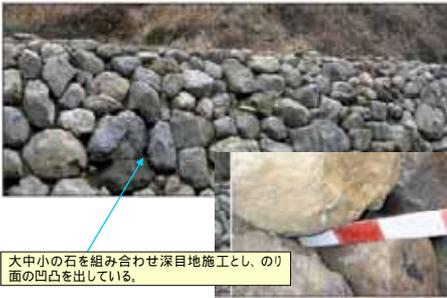
大中小の石を組み合わせ深目地施工とし、のり面の凹凸を出している。
