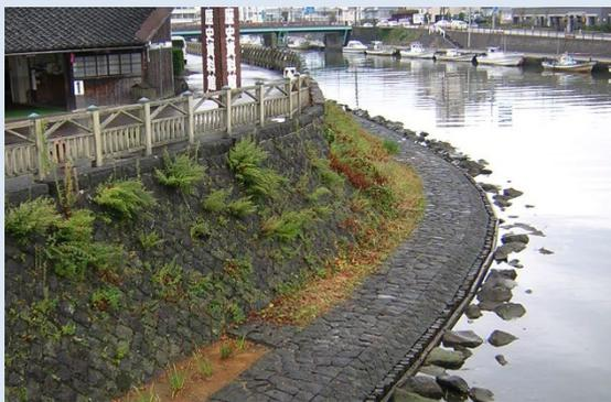
水辺の小段が、1枚のり面の護岸を横断方向に分節し、護岸の高さの印象を和らげる(新井田川)
