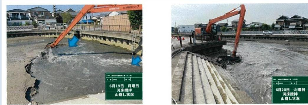
図 3.2-40 水圧と攪拌によりガタ土が浮遊し流れる状況
