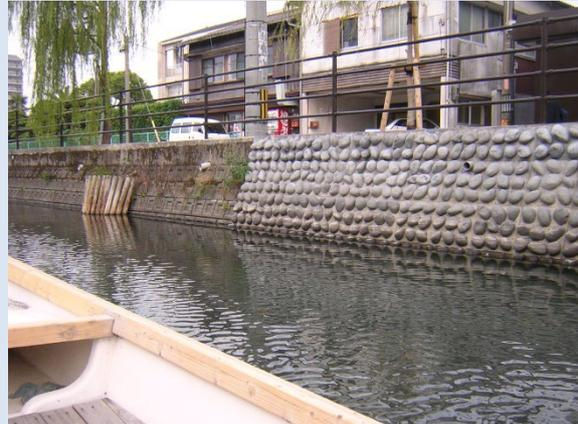
コンクリートに石を埋め込んだ護岸。一見石積み風だが、周辺の景観と調和しているとはいいがたい。また隣接するブロック護岸との関係も不自然で河川空間の一体感に欠けている。
