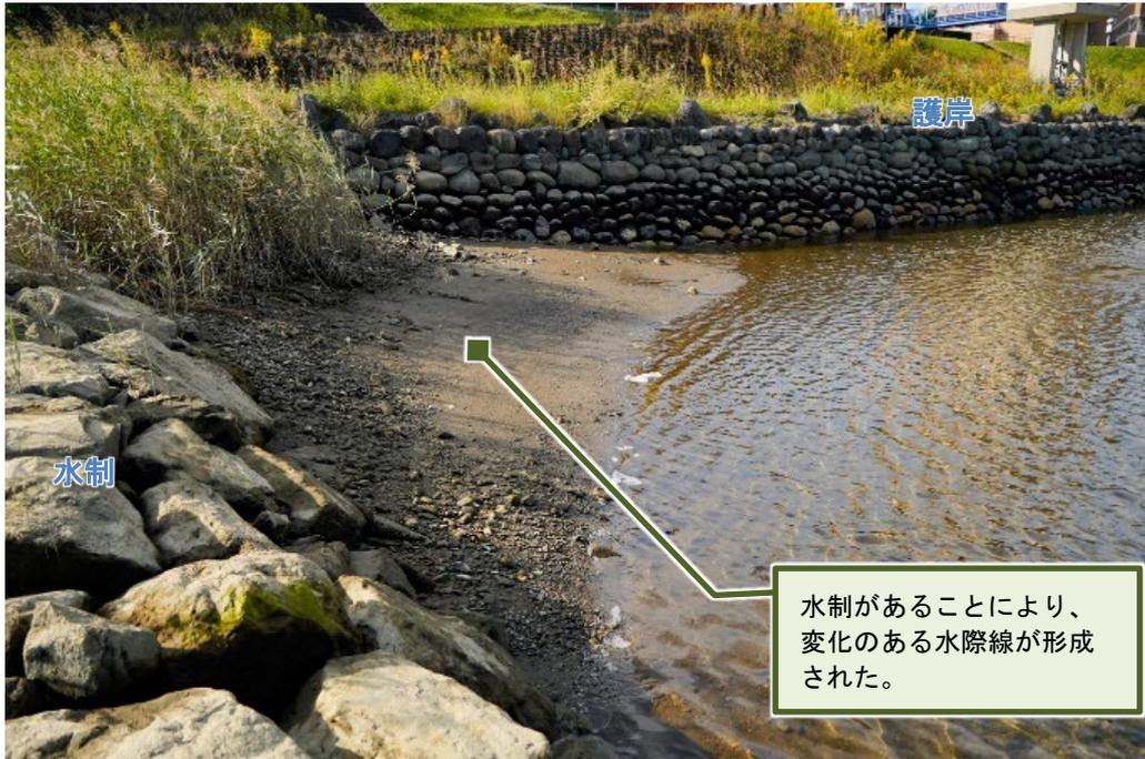
図 3.2-11 護岸と水制を併用。水制周りの土砂堆積により変化のある水際線を形成[五ヶ瀬川]
