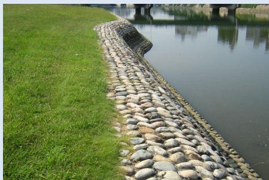
低水護岸をラウンド(丸みをつけて)処理し、護岸天端を草地にして、印象を和らげている(太田川)
