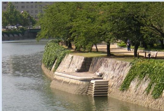
階段やテラスが流軸方向の連続性を分節し、縦断的に連続する護岸に変化を与えている(太田川)
