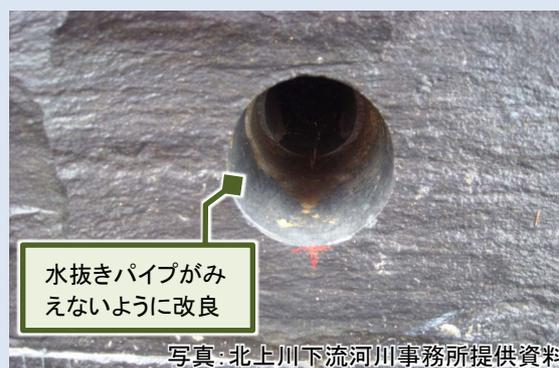
図 3.2-35 護岸から飛び出していた水抜きパイプを改良した事例（旧北上川）
