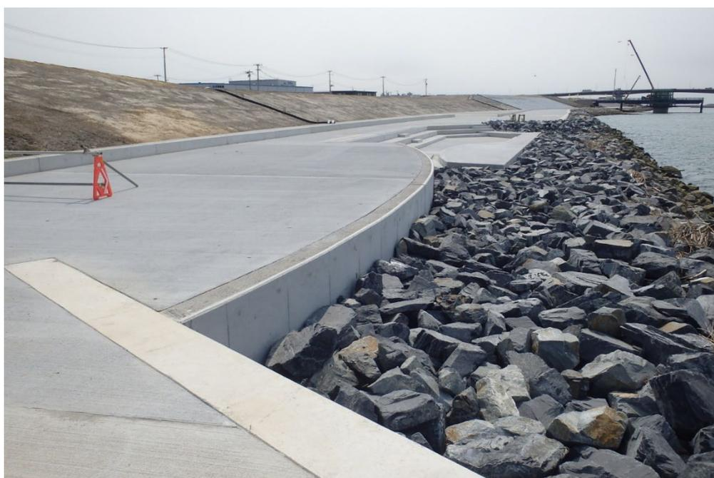
図 3.2-10 矢板護岸前面に捨石を配置[旧北上川]
