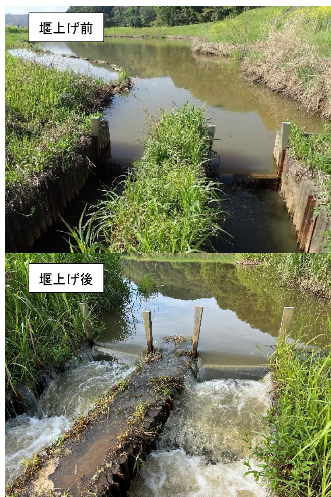
写真-1 閉鎖型湿地の堰上げ状況 (上：堰上げ前 下：堰上げ後)
