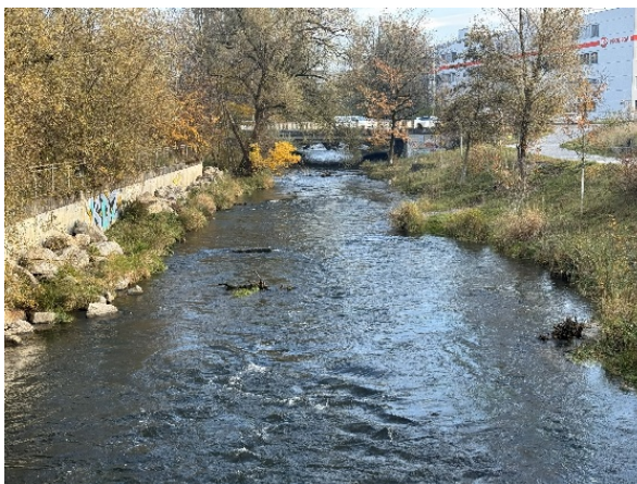
写真-2 グラット川の自然再生
