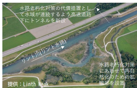
写真-2 リント川の拡幅部
