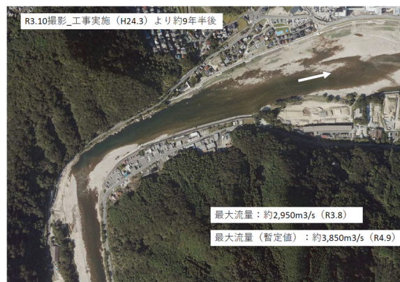
図-1 狭窄部の掘削箇所(湾曲部)付近の様子
