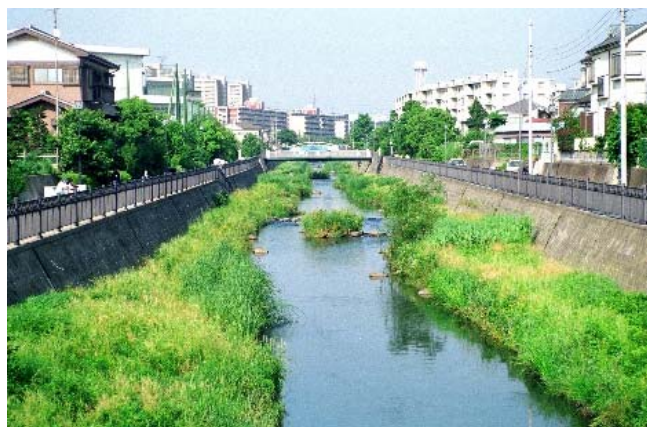
図-9 改修後のいたち川 9)
