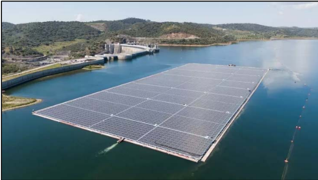
図-5 アルケヴァダムのフローティング PV の一部
