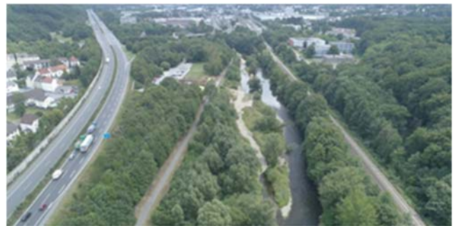
写真－3 高速道路近傍の状況
