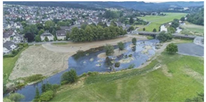
写真－1 エーヴェントロプ街区の状況
