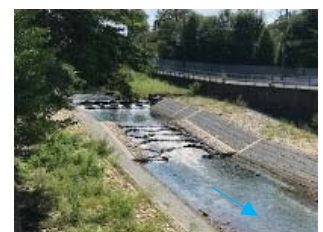
写真-2 改修済み区間の現況
