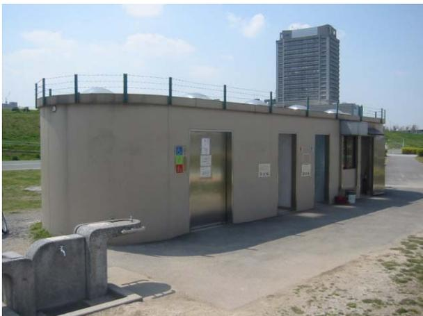
写真－2 平面形状を楕円形とし、流水の乱れに配慮した固定式トイレの整備事例
