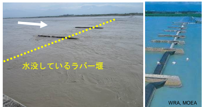
写真-6 高屏溪攔河堰（洪水時と平常時）
