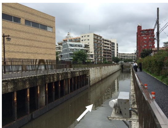
写真－1 神田川・環状七号線地下調節池取水口
