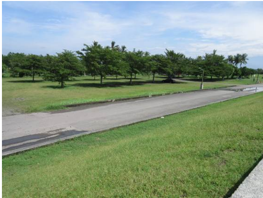
写真-4 阿里港河堤公園（左岸堤防上から望む）
