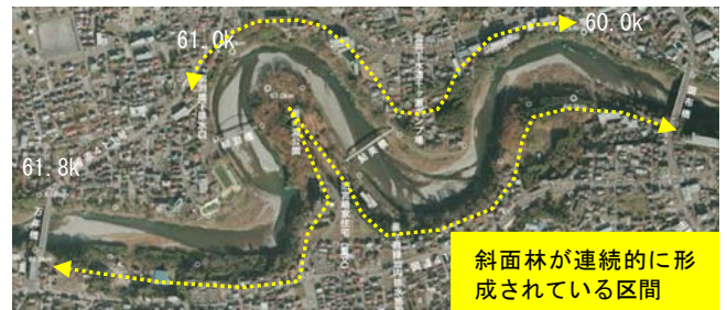
図-13 斜面林が連続的に形成されている区間の例(60.0k~61.8k 付近)
