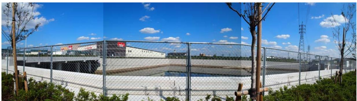
写真－6 新川支川五条川の伝法寺調整池（左側人工地盤上を駐車場として利用）
