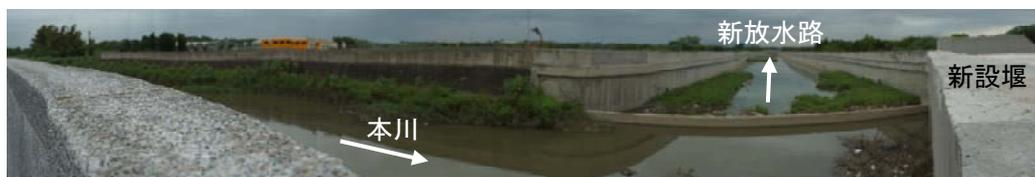
写真-2 港尾溝溪の放水路（左から本川、新放水路、本川を縦断する新設堰）
