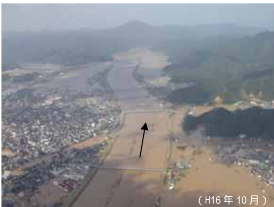
写真 - 1 台風第23号による浸水状況
