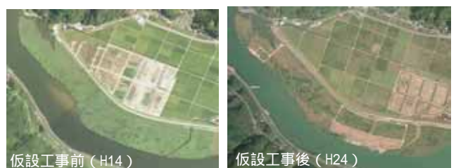
写-2 下鶴井地区の仮設工事前後
