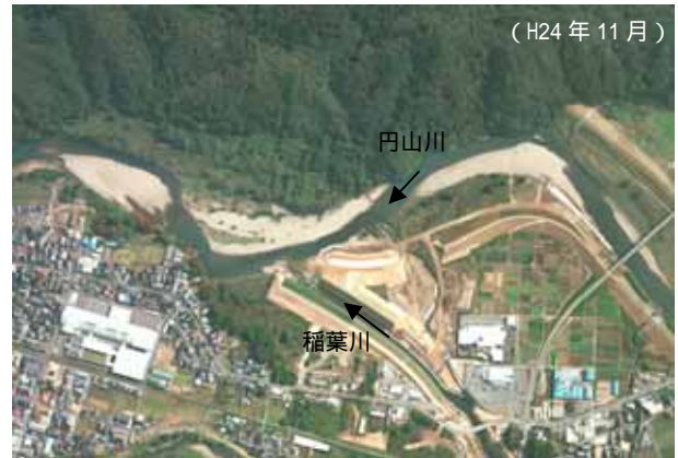
写 - 3 最上流区間で実施されている治水工事
