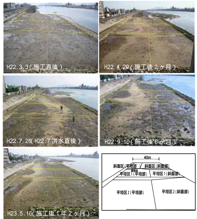
図-14 造成干潟の表層材料の変化(定点写真)
