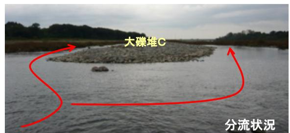
写真-3 大礫堆の設置により復元した複列流路
