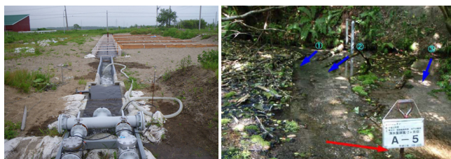
写真-1 伏没施設（左）と源流部の水位観測（右）
