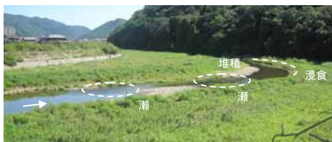
図 - 18 改良施工区間
