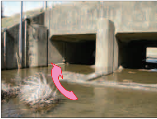
図-8 多孔質コンクリート壁による水の誘導と水深確保の例
