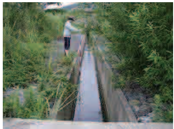
図-6 コンクリートの単調な水路
