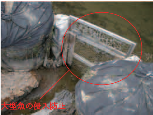
図-13 造成ワンド入り口に設けたブラックバス進入防止網
