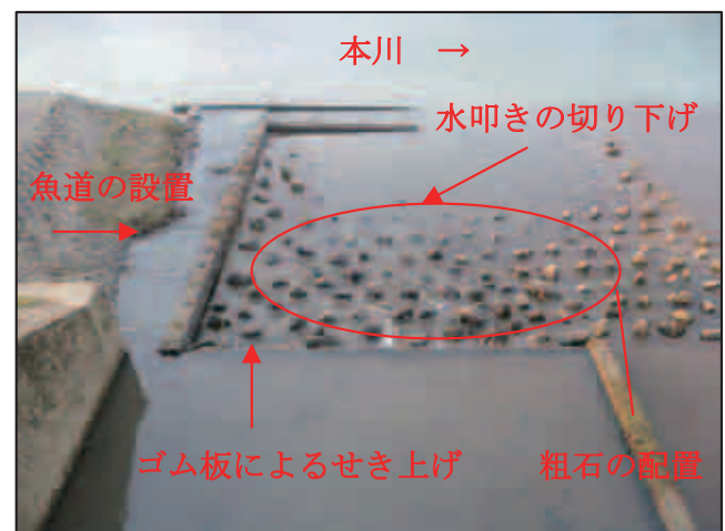
図-7 落差解消の例
