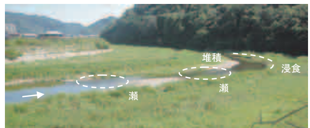
図-7 改良施工区間
