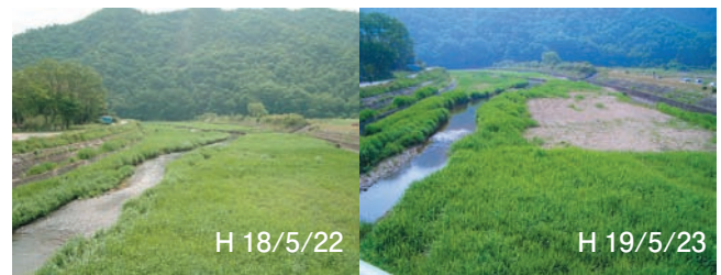
写真-2 高水敷切り下げ箇所（施工前後）
