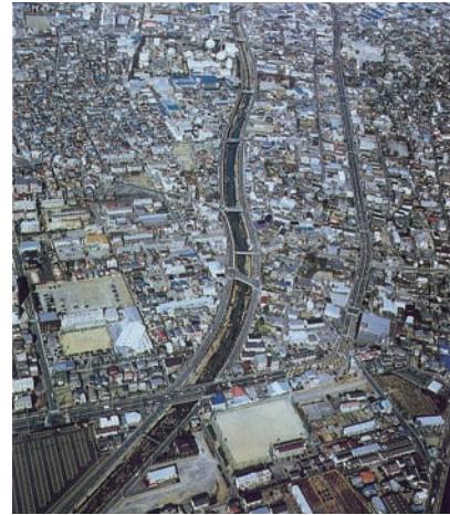
写真-4 多くの架橋の様子(大谷川放水路) 4)
