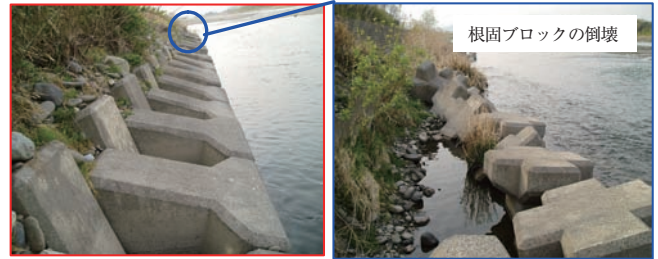
写真-4（1） 施工地区右岸の河岸状況
