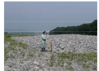
写真-5 施工した縦筋大礫堆
