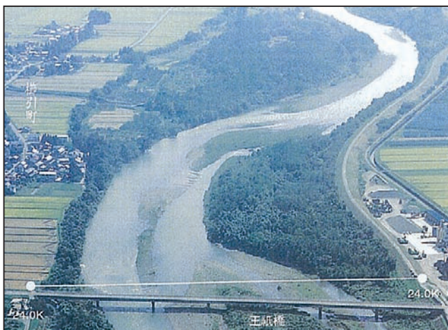
写真-1 ハリエンジュの繁茂した寄川
