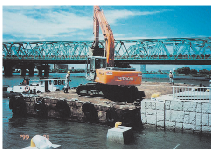
写真一5 緊急用船着場での重機搬入 （出典：荒川リバーステーション整備計画 荒川下流河川事務所）
