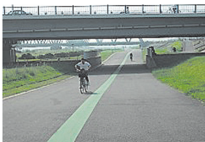
写真一3 緊急用河川敷道路
