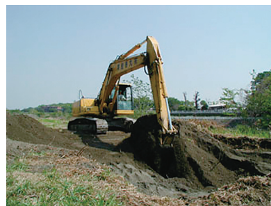
写真-3 河道掘削
