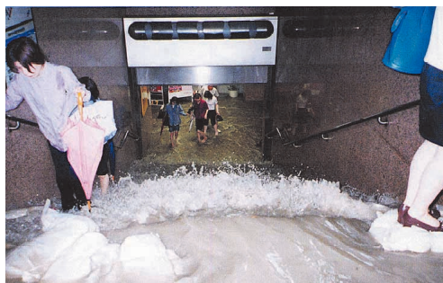
写真-4 地下鉄への浸水状況（平成11年：福岡市）
