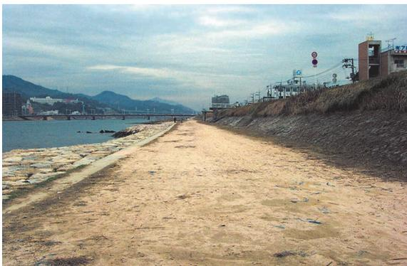
写真-4 太田川放水路に整備された緊急用河川敷道路
