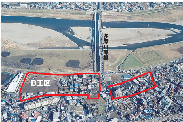
写真-4 矢野口地区B工区造成状況（平成14年）
