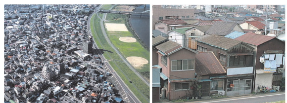
写真一1 河川沿いの密集した既成市街地
