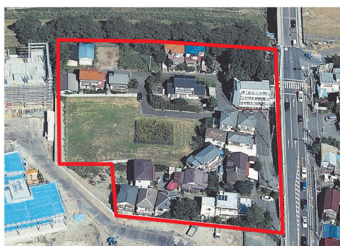
写真-6 共同事業区域の建物状況（平成14年）
