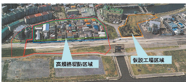
写真-3 平井7丁目地区の事業前の状況
