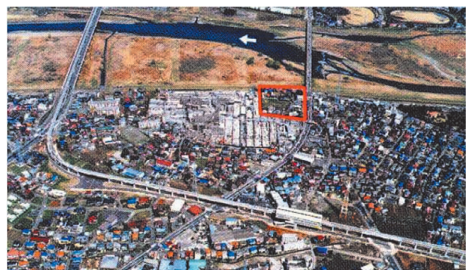
写真-5 モノレール完成状況
