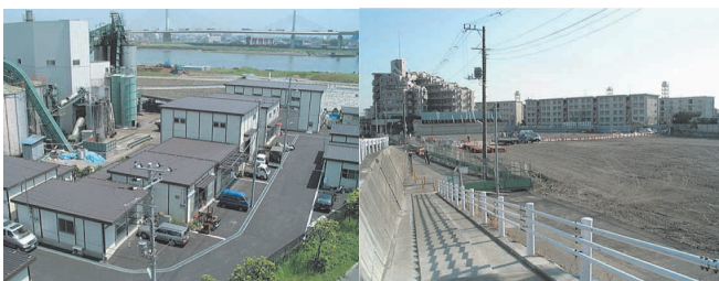
写真-4 仮設工場と移転完了状況（13年8月）
