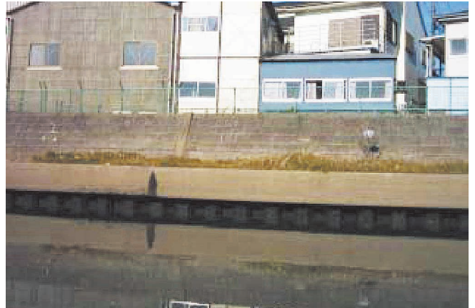
写真-3 水際の連続性が断たれている状況（綾瀬川）
