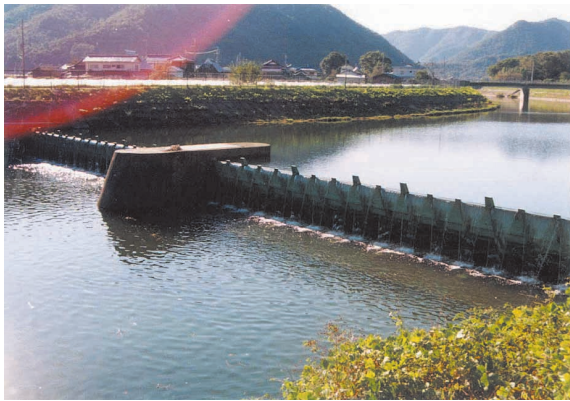
図一10 安室川の農業用取水堰
