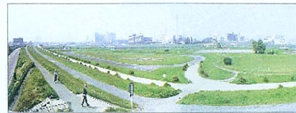
陸上トラックと走路の接続部
