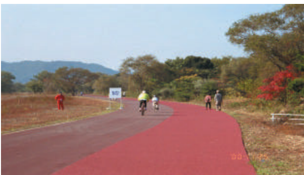
十分な舗装幅(ウレタン・アスファルト舗装)・大井川
