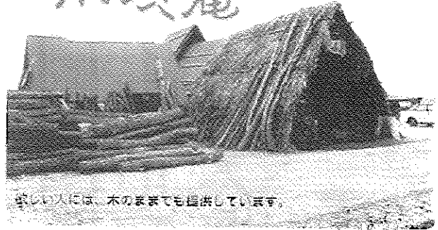
図-11 事務所が設置した炭焼き施設 (阿賀川工事事務所提供資料より)
