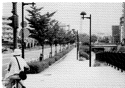
写真-2 一体的デザインによる施工
