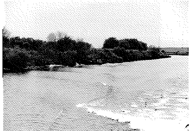
写真6 航走波の状況(荒川)
